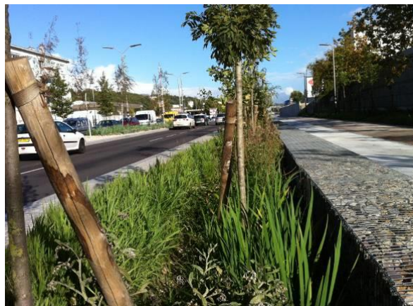
Exemples de réalisation de voirie avec noues plantées attenantes Source : Banque photo INFRA Services
