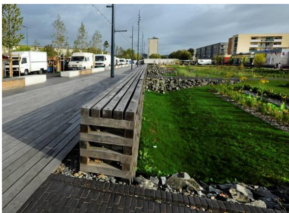
Exemples de réalisation de voirie avec noues plantées attenantes Source : Banque photo INFRA Services
