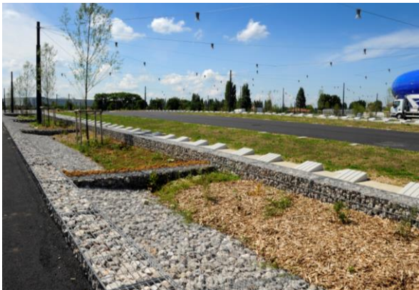
Exemples de noues à redans Source : INFRA Services
